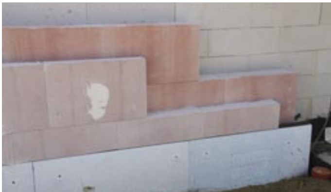
Der Wandaufbau wird aus 30 cm Ytong Thermoblock und 30 cm Multipor bestehen
