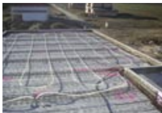
Startschuss für die Bauarbeiten war im Herbst 2008
