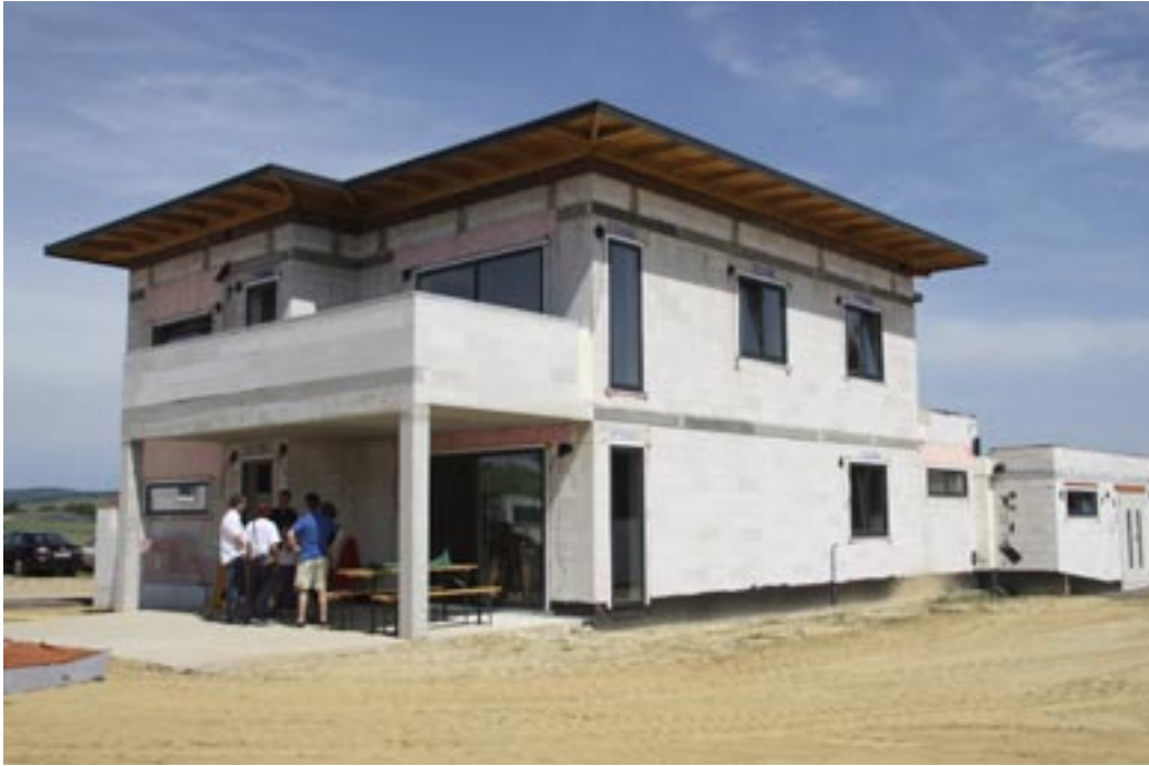
Der Rohbau des im August 2009 zu beziehenden modernen Passivhauses in Horitschon steht bereits
